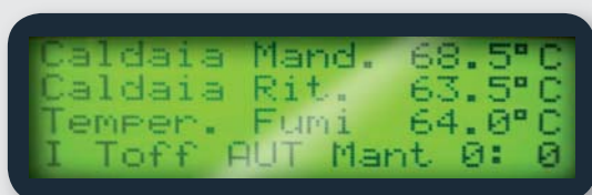
Letture delle sonde di mandata, ritorno caldaia, temperatura dei fumi.
