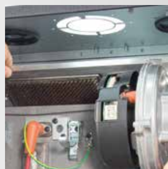
Vytočení spalovacího systému
