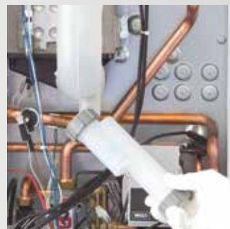
Demontáž sifonu kondenzátu
