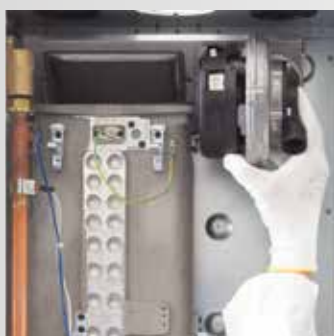
Demontáž spalovacího systému
