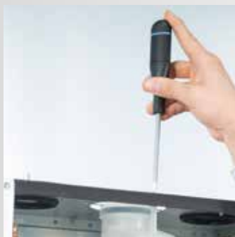
Osšroubování šroubu sběrného odvodu spalin
