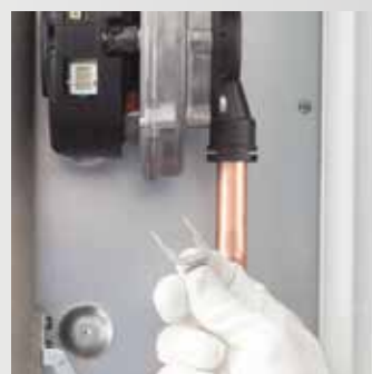
Demontáž plynového potrubí
