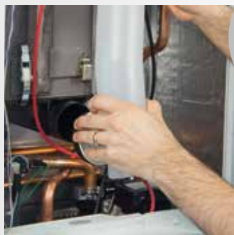
Demontáž sběrného odvodu spalin
