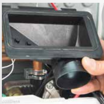
Demontáž sběrače kondenzátu
