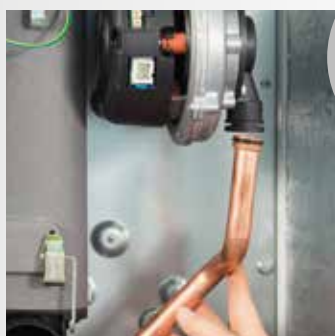
Sejmutí plynového potrubí
