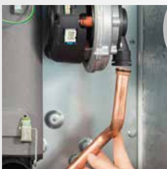
Sejmutí plynového potrubí
