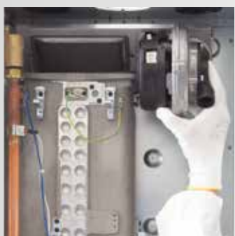
Demontáž spalovacího systému
