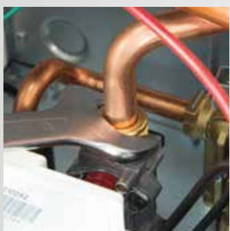
Uvolnění potrubí plynového ventilu
