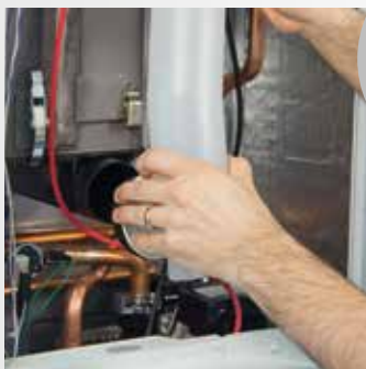
Demontáž sběrného odvodu spalin
