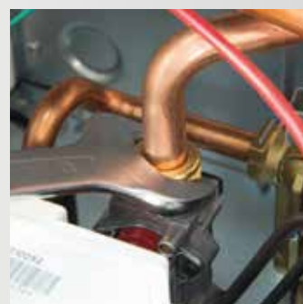
Demontáž plynového potrubí
