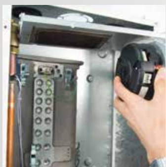
Odstranění kompletního systému spalování
