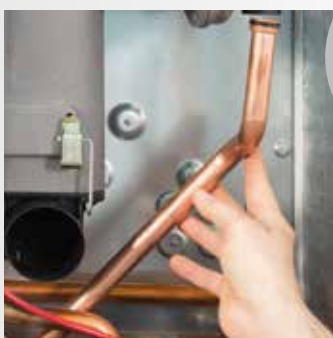
Vyjmutí plynové trubky
