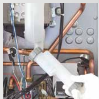
Demontáž sifonu kondenzátu
