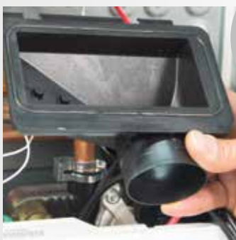
Vyjmutí sběrače kondenzátu
