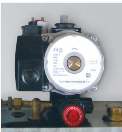
Tělo čerpadla se zabudovaným odvětráním
