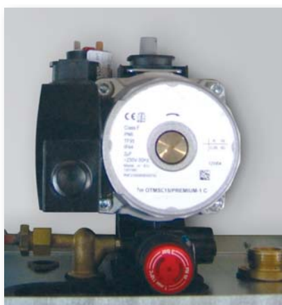
Tělo čerpadla se zabudovaným odvětráním
