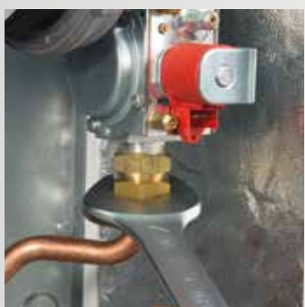
Odšroubování převlečné matice na plynovém ventilu
