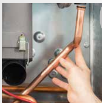
Vyjmutí plynové trubky
