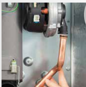
Sejmutí plynového potrubí
