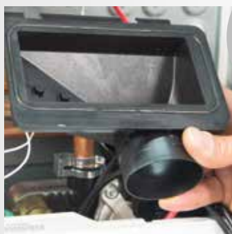
Demontáž sběrače kondenzátu
