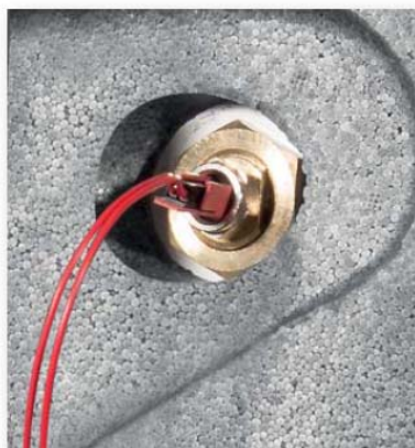
Sonda TUV v bojleru a izolace ze samozhášivé pěny
