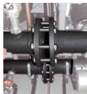
Jednoduchá montáž (detail spojení příruba/příruba)
