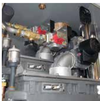
Jednotky: ventilátor, modulační plynový ventil, premixový hořák.
